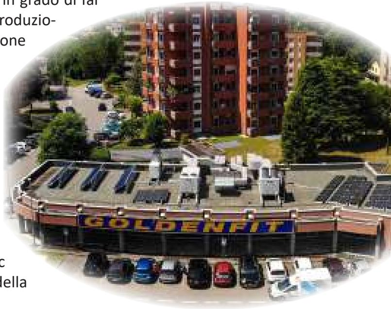
posizionati con un orientamento (sud) e un'inclinazione (30°) in modo da poter ottenere il massimo rendimento possibile.
