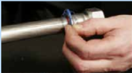
Fig. 4 lacerazione e rimozione manuale dello sleeve dopo la pressatura
