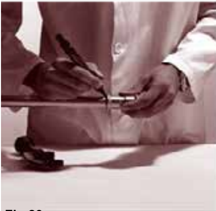
Fig. 23 Inserimento dei tubi nei raccordi e segnatura del corretto posizionamento
