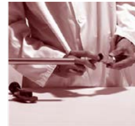
Fig. 22 Verifica della presenza e del posizionamento degli o-ring
